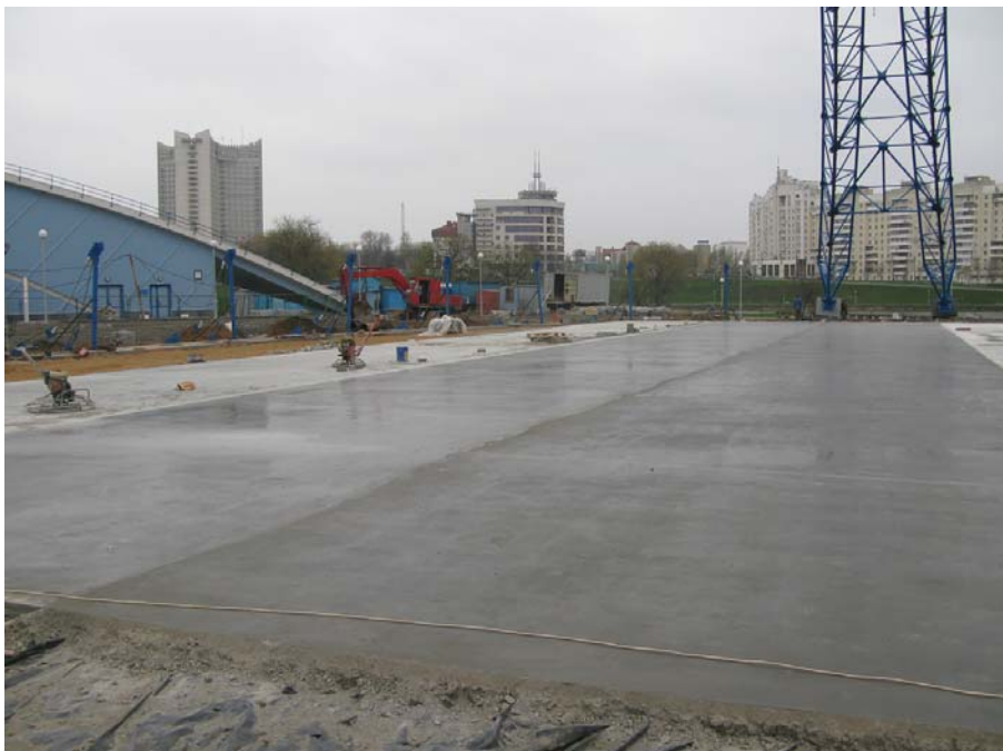
Рисунок 16 Общий вид монолитной плиты катка из сталефибробетона класса С30/37 после нанесения упрочняющего покрытия (тип полов I)
