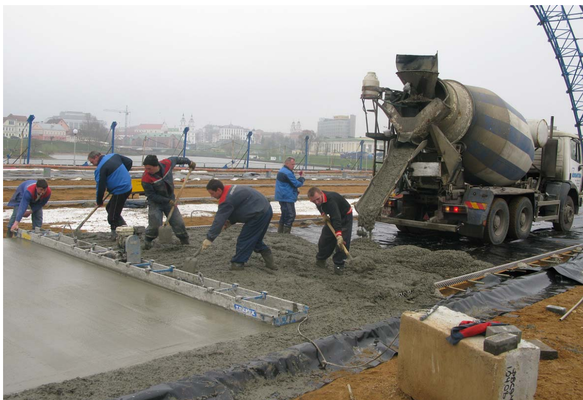
Рисунок 15 Укладка сталефибробетонной смеси с уплотнением виброрейкой на отдельной полосе плиты толщиной 160 мм. Фибра фрезерованная ЗАО «Курганстальмост», расход 60кг/м 3 . Мобильный сезонный каток в г.Минске
