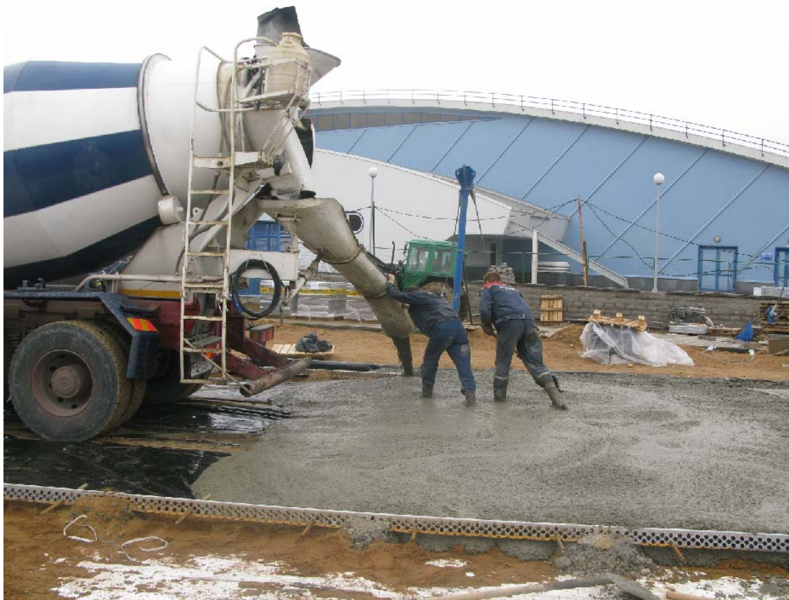
Рисунок 14 Процесс выгрузки сталефибробетонной смеси с маркой удобоукладываемости П4 из автобетоносмесителя при устройстве монолитной плиты толщиной 160 мм мобильного катка по пр. Победителей г.Минск
