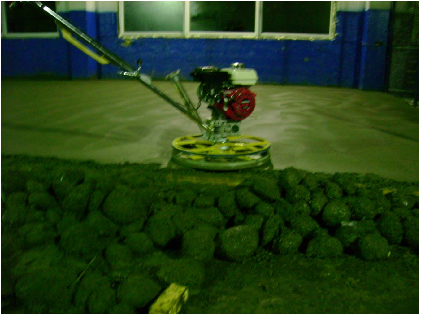
Рисунок 10 «Классический» пример образования «ежей» из стальной фибры (на переднем плане) в процессе устройства монолитных полов
