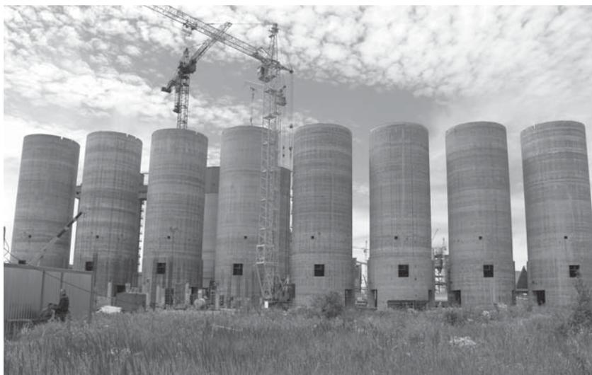
**Рисунок 9.** Монолитные железобетонные силосы для хранения цемента
