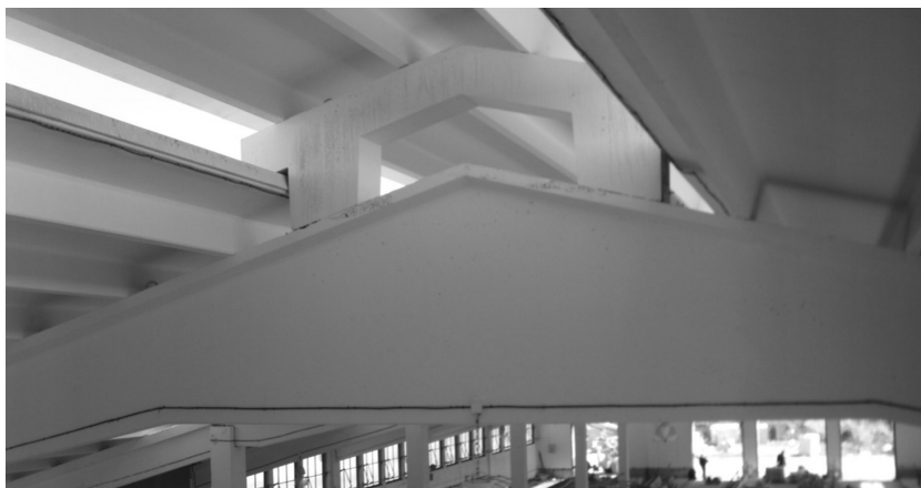
Рисунок 2. Стропильная конструкция среднего пролета здания
