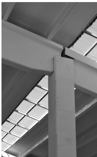
Рисунок 3. Узел опирания стропильных балок на среднюю колонну
