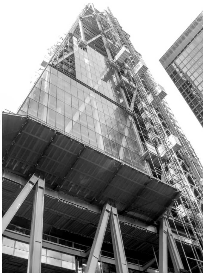
Рисунок 6. Система подачи материалов при строительстве башни The Leadenhall
