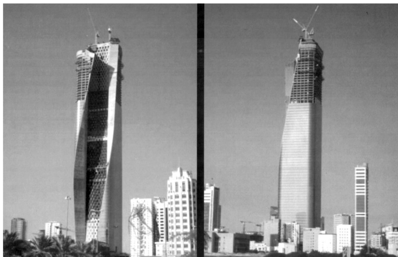
Рисунок 9. Технология самоподъемных кранов при строительстве высотного здания
