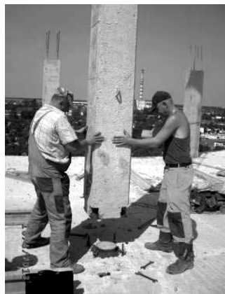
Рисунок 5. Монтаж сборной колонны
