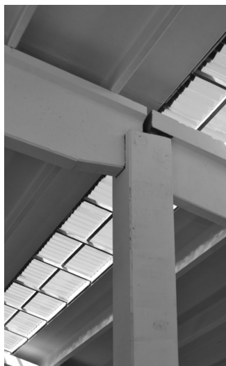
Рисунок 3. Узел опирания стропильных балок на среднюю колонну
