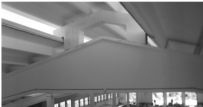
Рисунок 2. Стропильная конструкция среднего пролета здания
