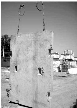
**Рисунок 2.** Сборная панель шахты лифтов
