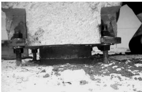
**Рисунок 4.** Анкерные выпуски из монолитной плиты с креплением к колонне
