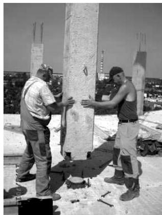
**Рисунок 5.** Монтаж сборной колонны
