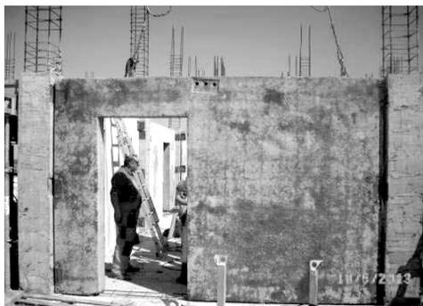
**Рисунок 3.** Сборная панель диафрагмы жесткости
