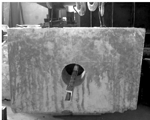
Рисунок 1. Фундаментный блок с армированием одиночным швеллером № 6,5
