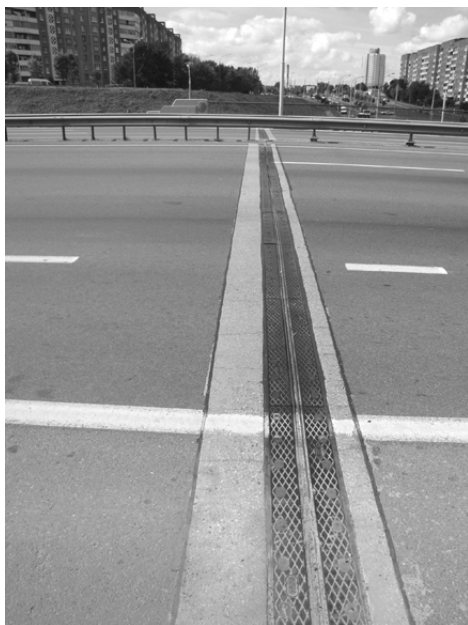
Рисунок 6. Минская кольцевая автодорога, км 8 (ДШ устроен в 2008 г.)
