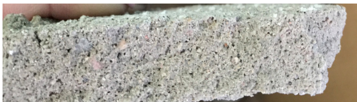
Рисунок 5. Структура бетона с отсутствием крупного заполнителя
