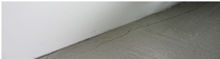
Рисунок 3. Трещины при твердении бетона
